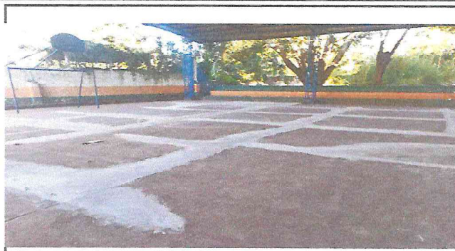
Foto 2: Nivelación de tortas de concreto en la cancha de basquetbol
