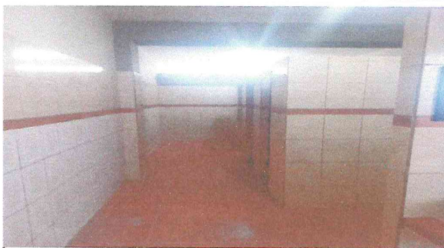
Foto 3: Remodelación de Baños de mujeres
