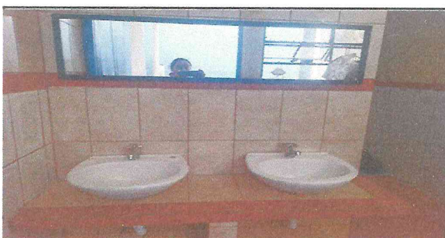
Foto 5: Instalación de Lavamanos
